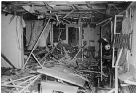
Zerstörte Lagebesprechungsbaracke nach dem Anschlag
